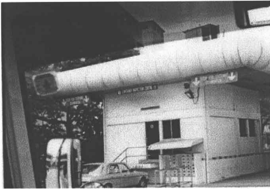
ภาพถ่ายที่ 3 : จุดตรวจสอบศุลกากรที่ทางเข้า-ออกท่าเรือ (Container Inspection Center)
