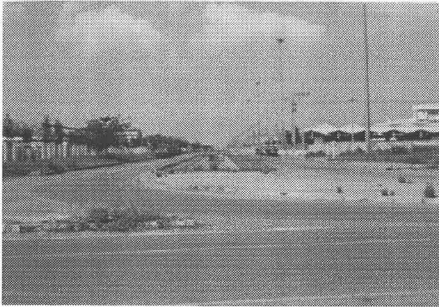
ภาพถ่ายที่ 11 : พื้นที่ว่างด้านเหนือ ICD ลาดกระบัง
